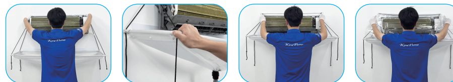
1.打開挂上清洗槽 2.拉緊繩扣 3.扣上防護罩支架 4.蓋上防護罩單佈
